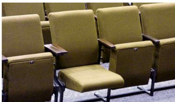
Bei den alten Stühlen ist die Polsterung verschlissen und auch die Klapp-technik ist teilweise defekt.
