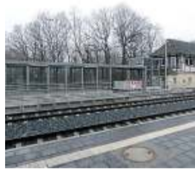
Blick auf die neue Unterführung
