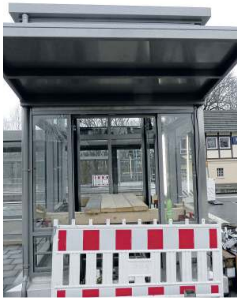
Derzeit werden Fahrstühle eingebaut.
